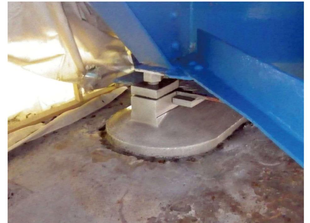
アルマグ溶射とは、環境にやさしく防食性に優れたアルミ・マグネシウム金属溶射により鋼材の防錆を行う工法です。
