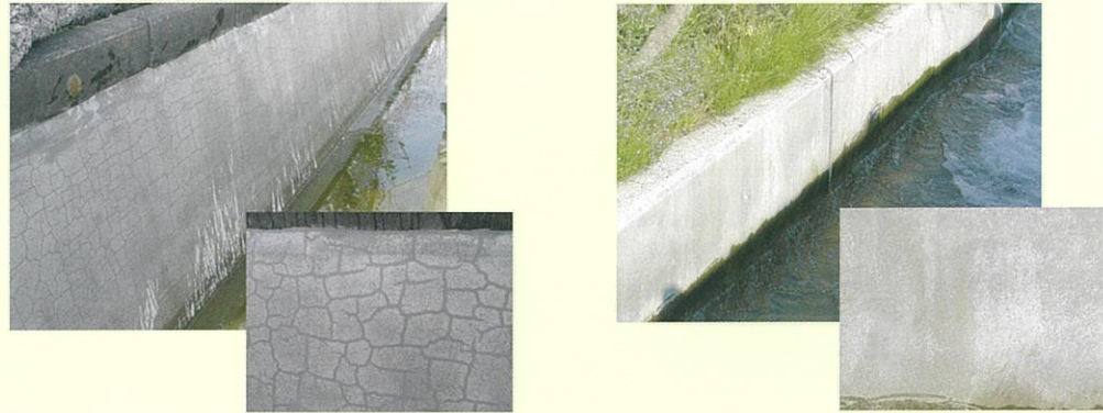
ポリマーセメントモルタル
