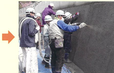
モルタル吹付け工
