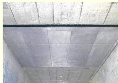
道路ボックスカルバート
