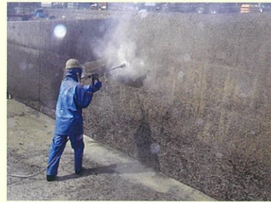
下地処理工 (WJ工法)
