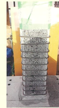
帯筋による補強
