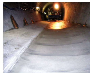
トンネル底板補修
