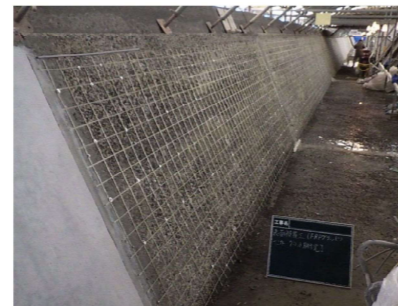
グリッド筋を併用した補強
