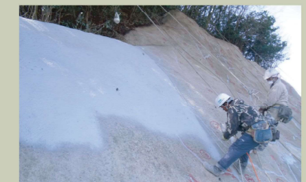
⑦ 柔性モルタルライニング
