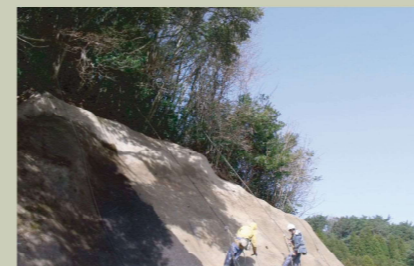
③ 下地処理工（洗浄・目粗し）
