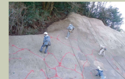
④ ひび割れマーキング・測定工
