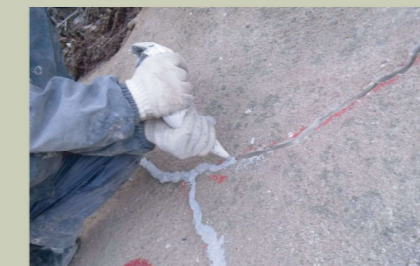
⑤ ひび割れ充填工
